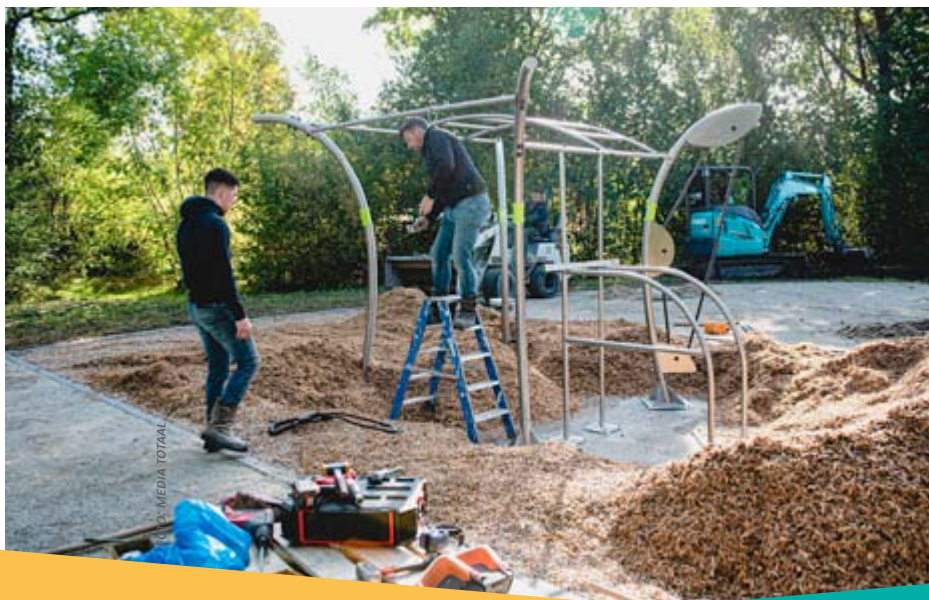
Aanleg Beweegpark Roderveld. FOTO: MEDIA TOTAAL RODEN
