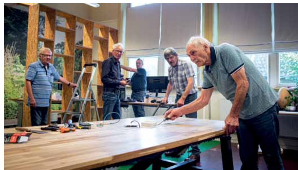
Mannen van de Klussendienst verbouwen locatie Scheepstra. Foto: De Krant-Media Totaal
